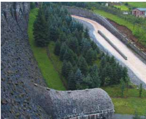
Talsperre mit Hochwasserentlastung
