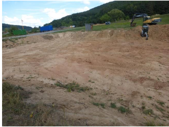
Abgrabung / Blick Ri Norden (Quelle: Foto Michael Maier / 07.09.2022)
