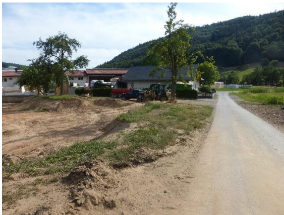
Abgrabung / Blick Ri Westen (Quelle: Foto Michael Maier / 07.09.2022)
