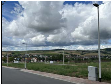
Elf Bauplätze sind im neuen Gebiet „Wildensteiner Straße Ost“ in Eschau entstanden.
