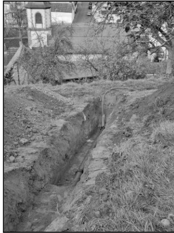
Bau der neuen Einspeise- und Entnahmeleitung am Hochbehälter Hobbach im Rahmen der Neustrukturierung der Wasserversorgung
