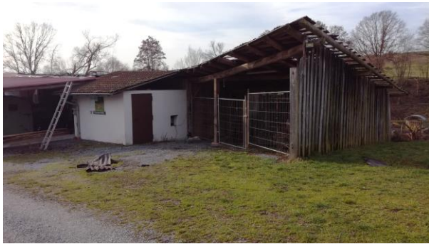
Abzubrechendes Nebengebäude und Unterstellhalle
