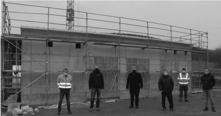
Foto: Martin Roos (v.l.n.r): Wasserwart Reinhold Schäfer, Bauleiter Kai Heiß- ner, Firma Baurcon- sult (Haßfurt), 1. Bgm. Gerhard Rüth, Geschäftslei- ter Walter Wölfel- schneider, Bauhof- leiter Rudolf Fuchs & Bauamts- mitarbeiter Stephan Frobenius an der Baustelle am Wasserwerk Eschau
