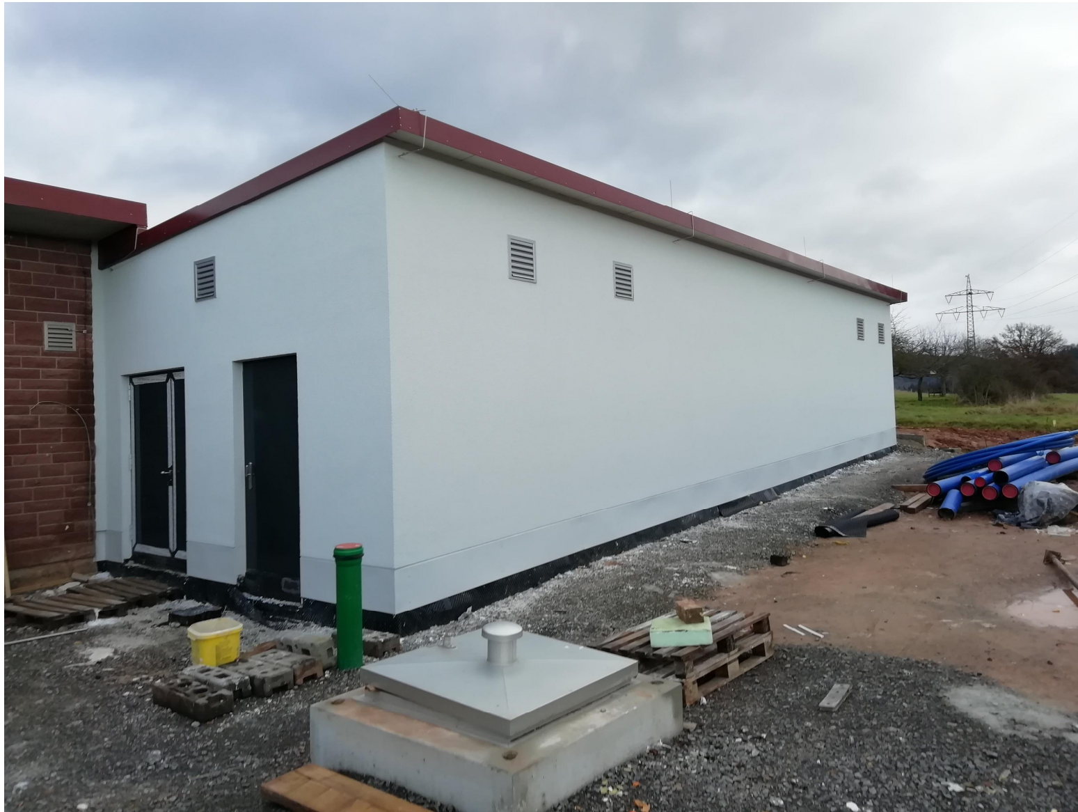
Anbau neues Wasserwerk Eschau
