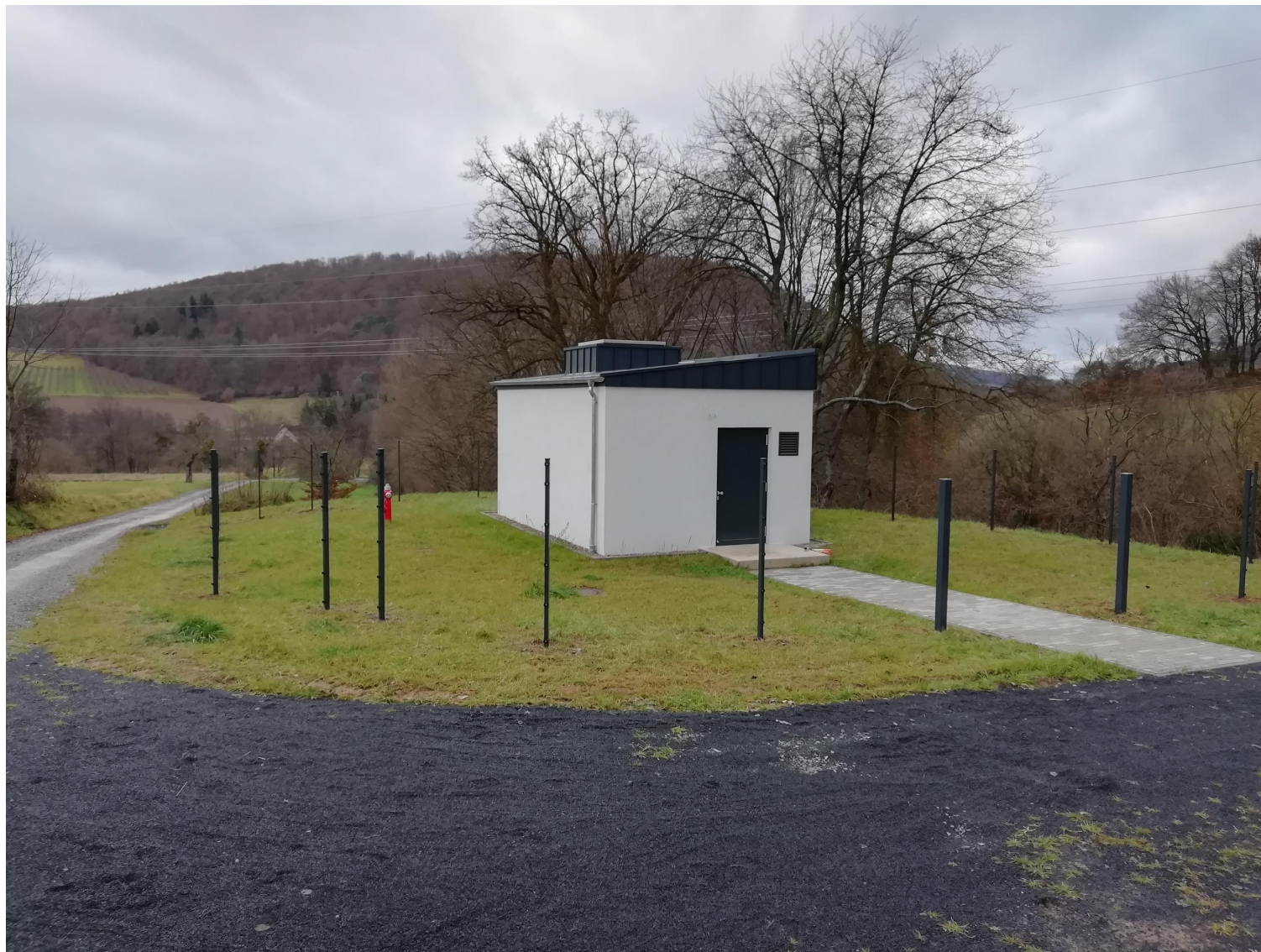
Fertiges Brunnenabschlussbauwerk - Vorderseite
