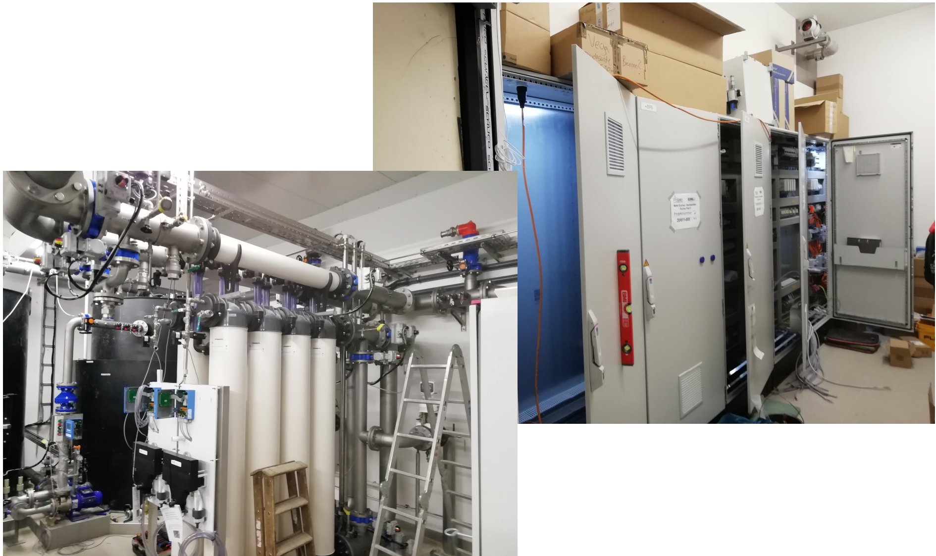
Installation der Hydraulischen Ausrüstung und Elektrotechnik
