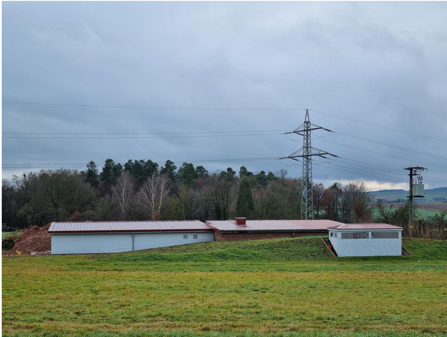
Rückseite am Wasserwerk und Hochbehälter Eschau
