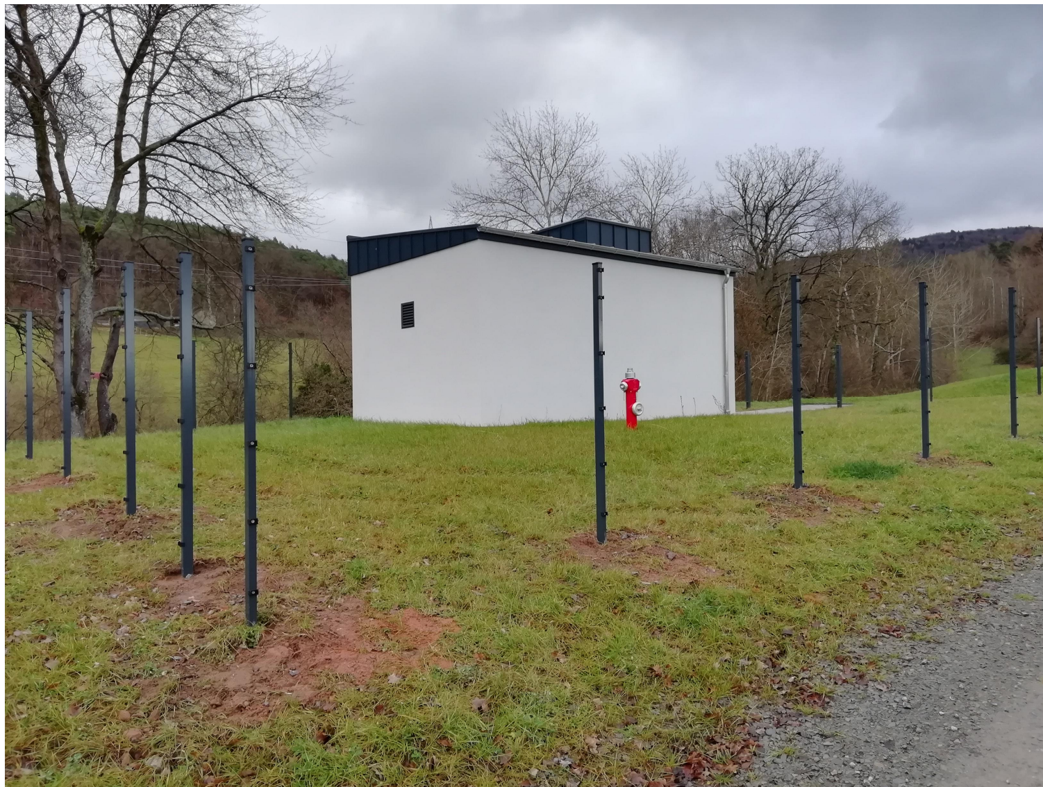
Fertiges Brunnenabschlussbauwerk - Rückseite
