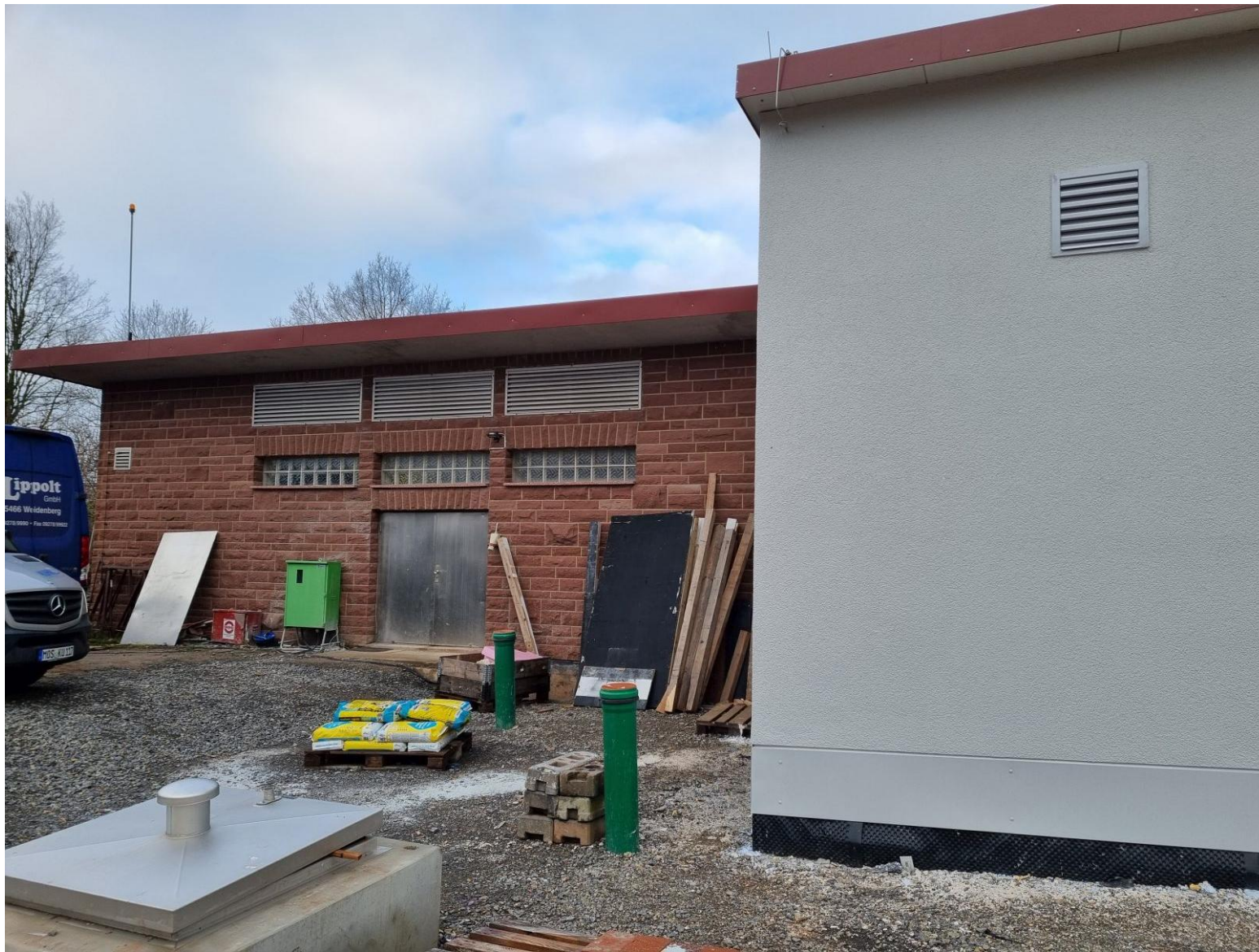
Vorderseite Wasserwerk und Hochbehälter Eschau
