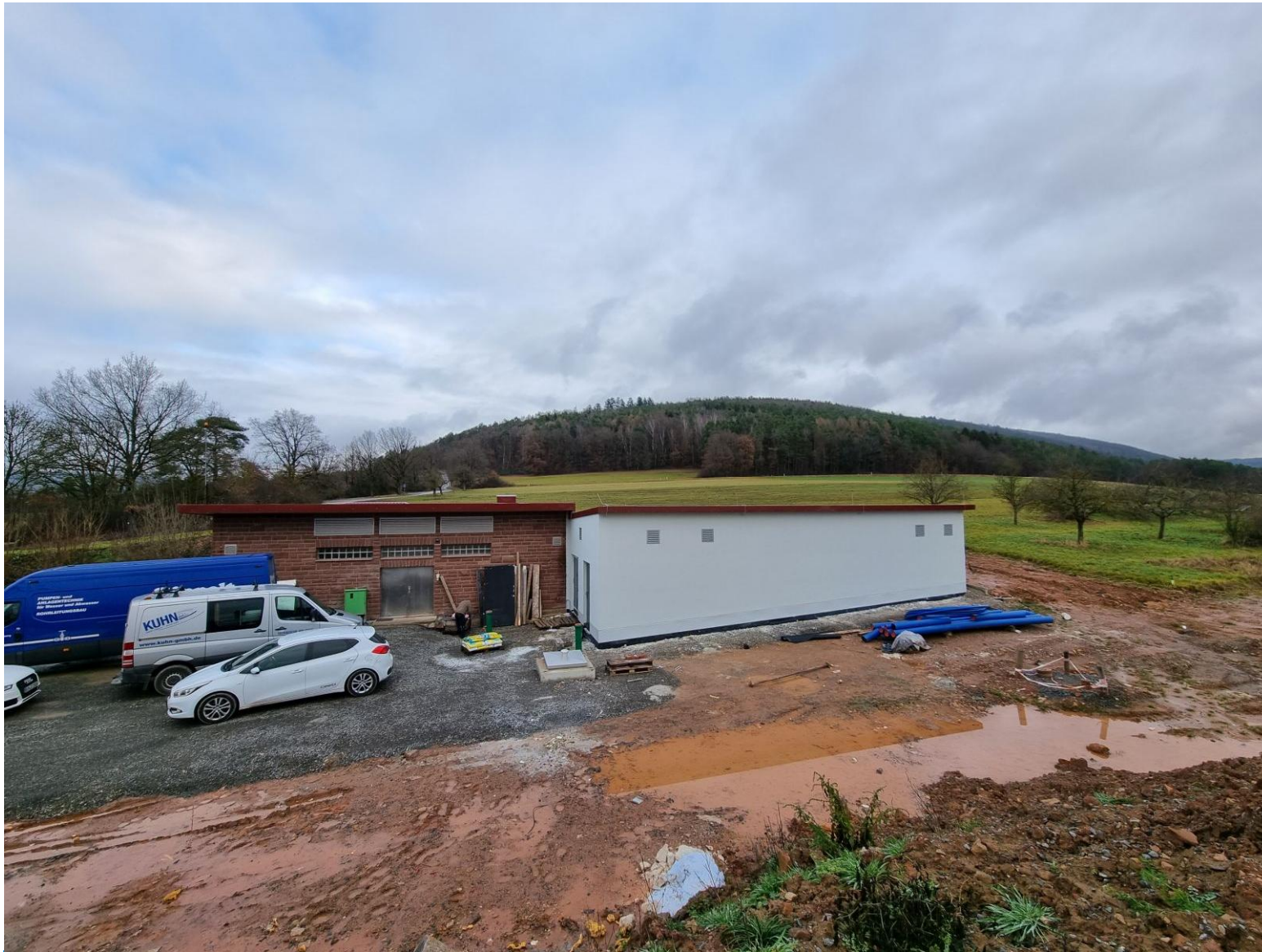
Vorderseite Wasserwerk und Hochbehälter Eschau
