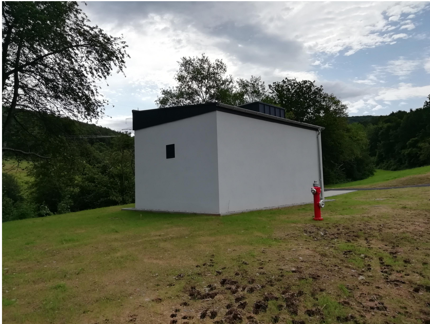
Fertiges Brunnenabschlussbauwerk - Rückseite
