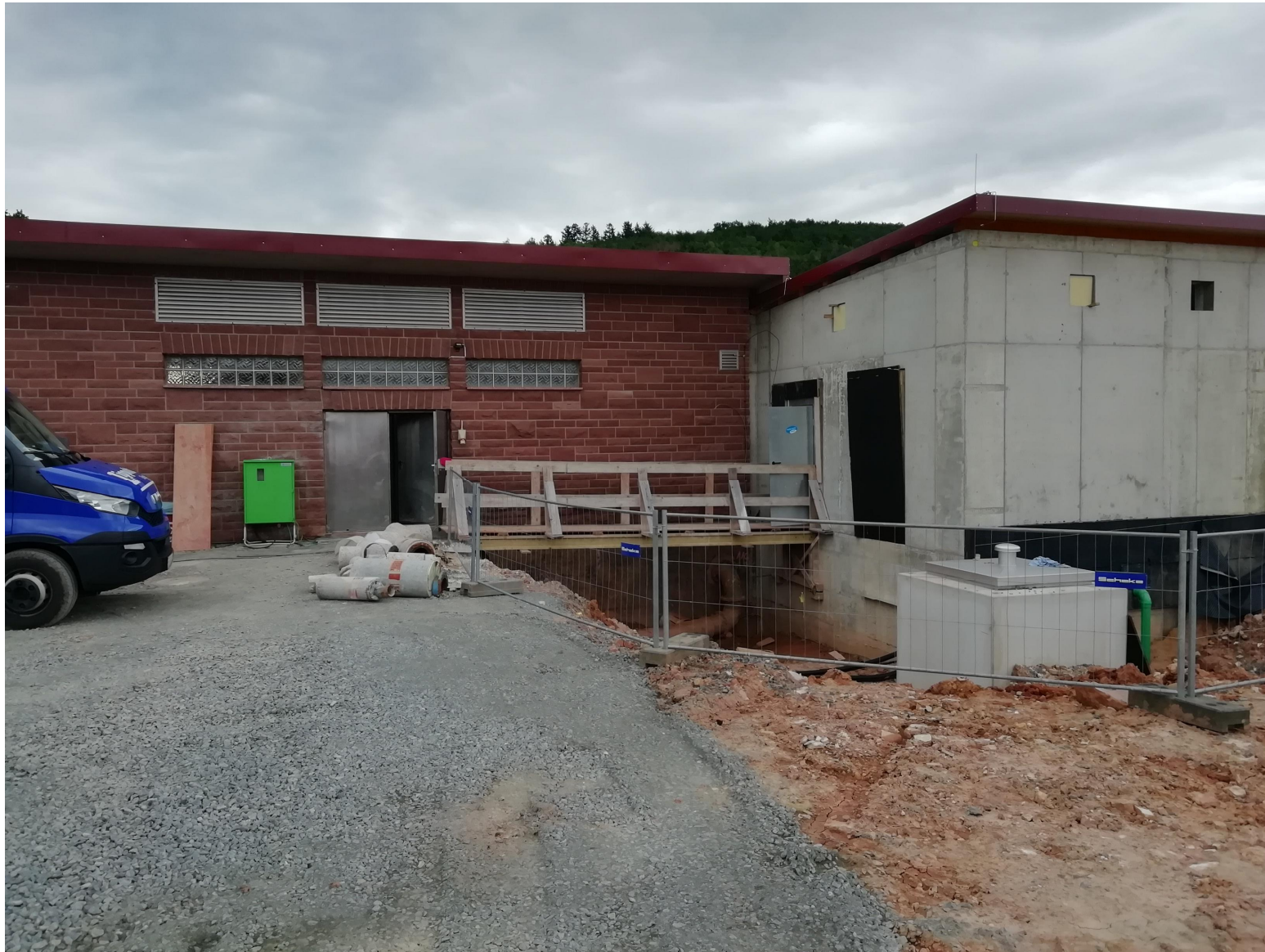
Außenanlagen am Wasserwerk und Hochbehälter Eschau
