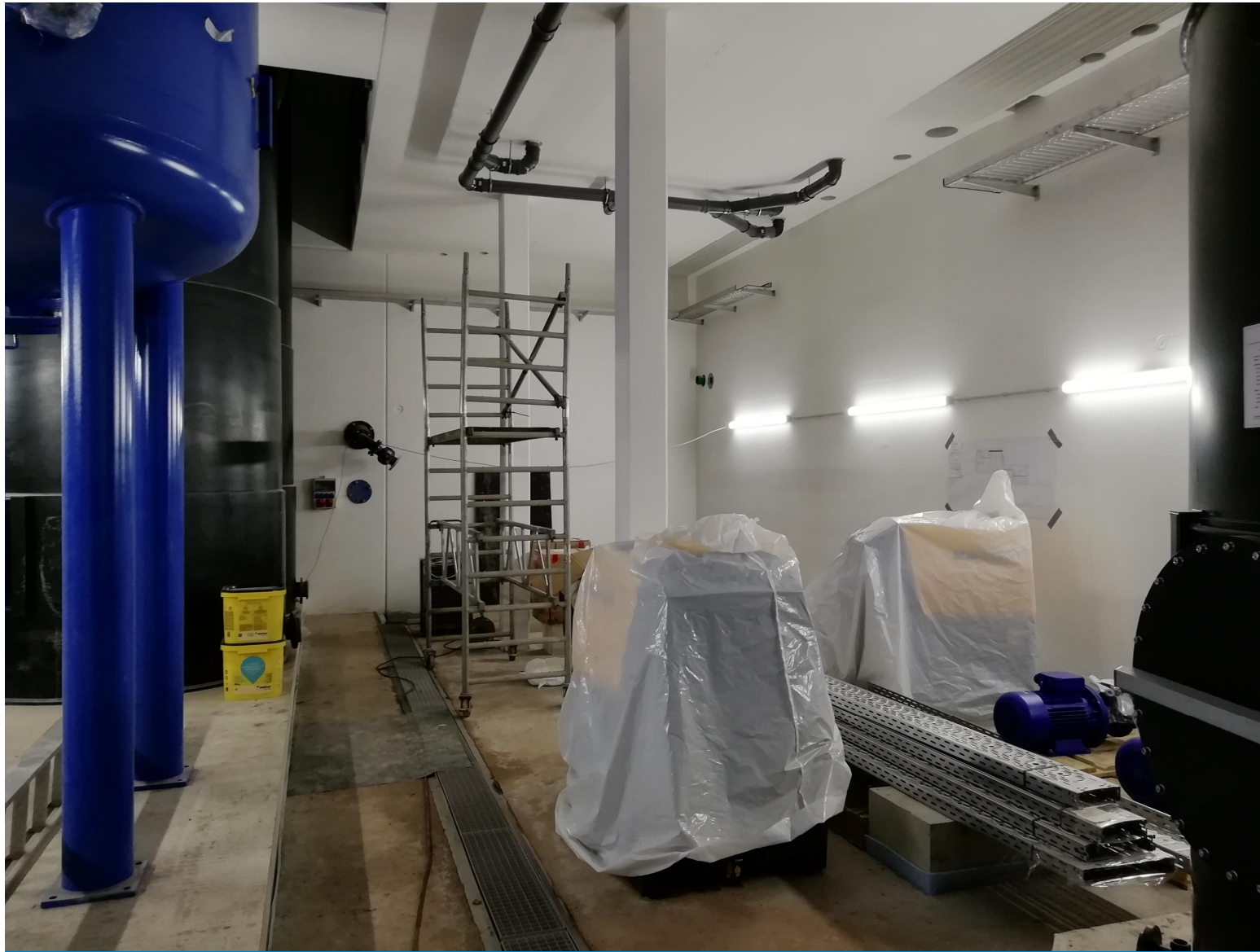
Installation der Hydraulischen Ausrüstung und Elektrotechnik
