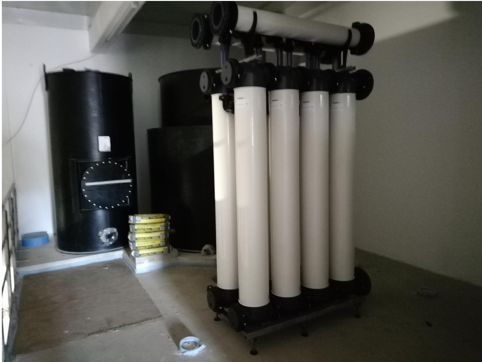
Installation der Hydraulischen Ausrüstung und Elektrotechnik
