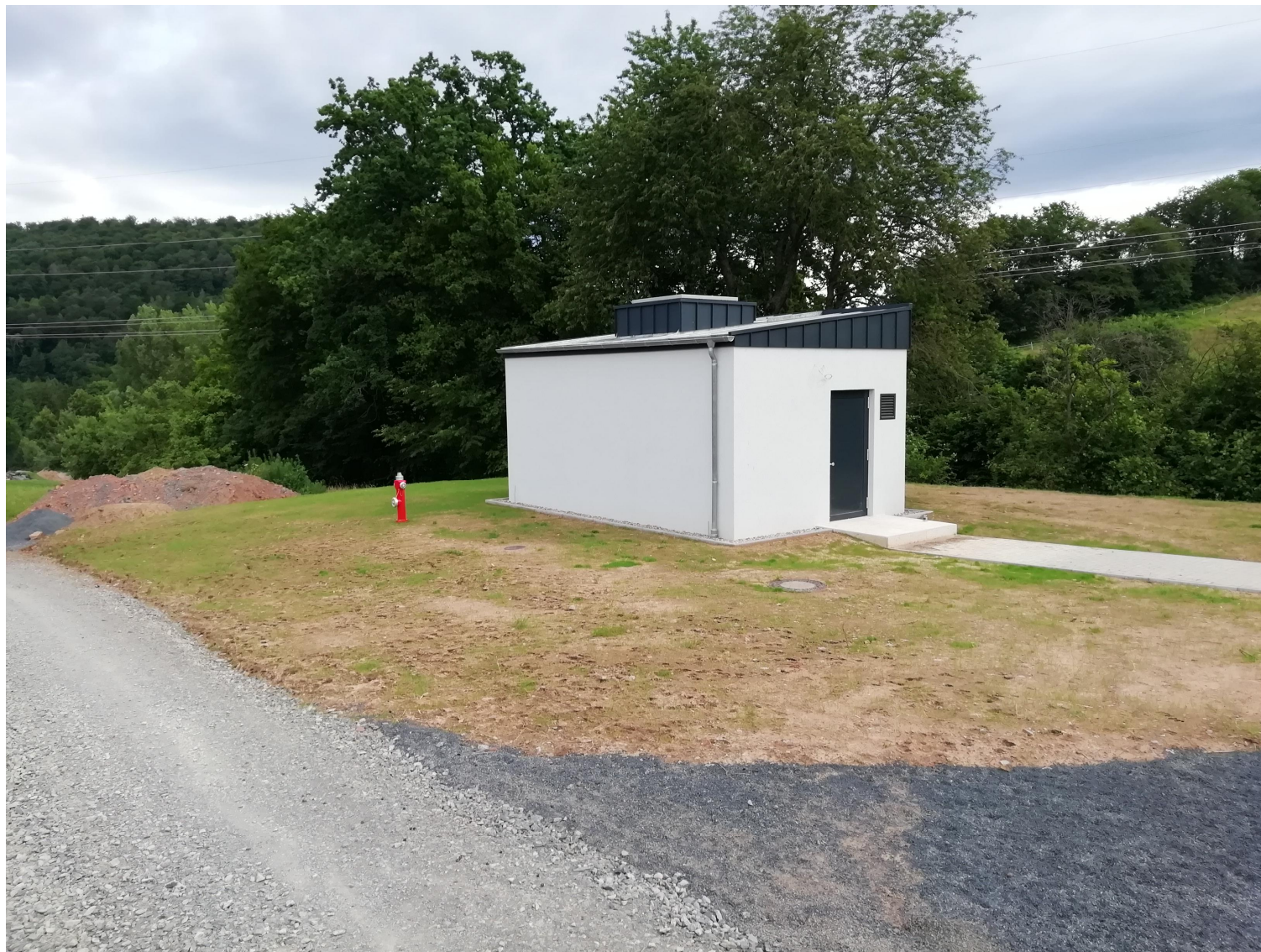
Fertiges Brunnenabschlussbauwerk - Vorderseite
