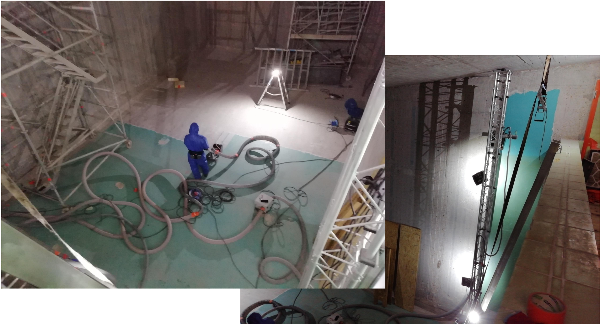
Abtrag alte Beschichtung in der Wasserkammer
