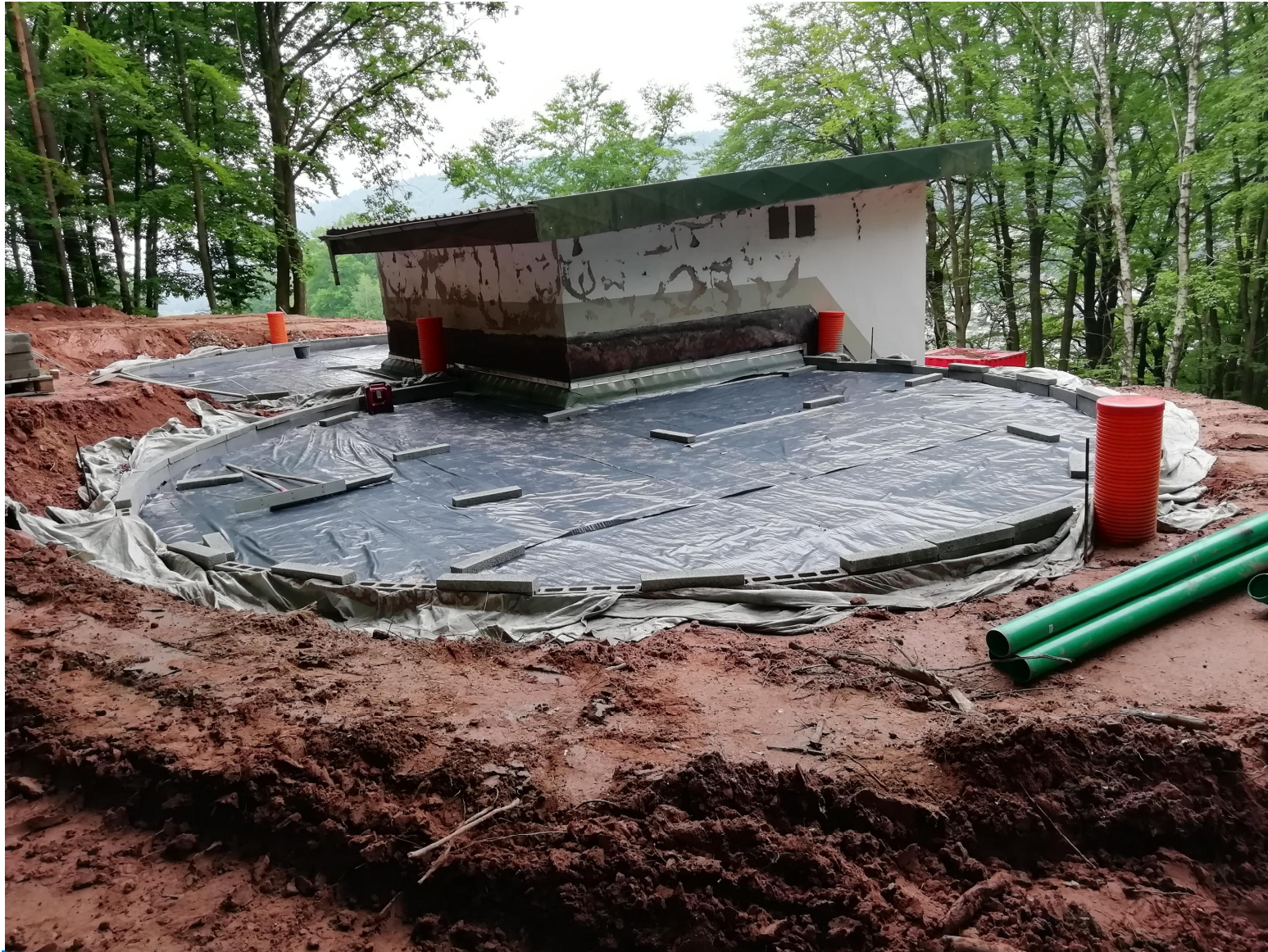
Abdichtungsarbeiten Hochbehälter Hobbach
