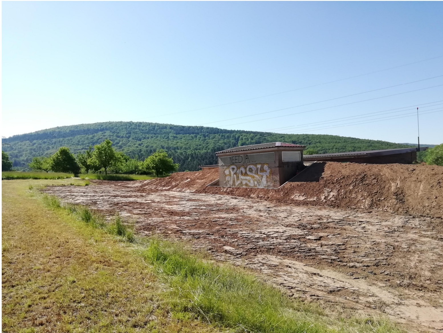
Außenanlagen am Wasserwerk und Hochbehälter Eschau
